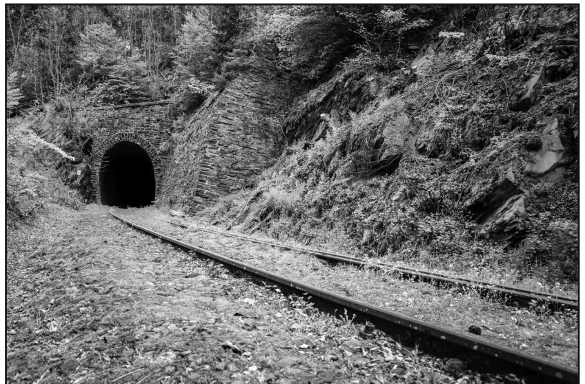
Ziemestalbrücke und Tunnelportal an der Oberlandbahn (Fotos: K. Wisotzki)
